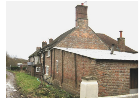
Fig. 20 No 1 Vyse Barn Cottages
